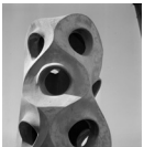
Joaquim Gomis Detall d'una de les torres de ventilació del terrat de La Pedrera 1946 Còpia moderna Fons Gomis, dipositat a l'Arxiu Nacional de Catalunya
